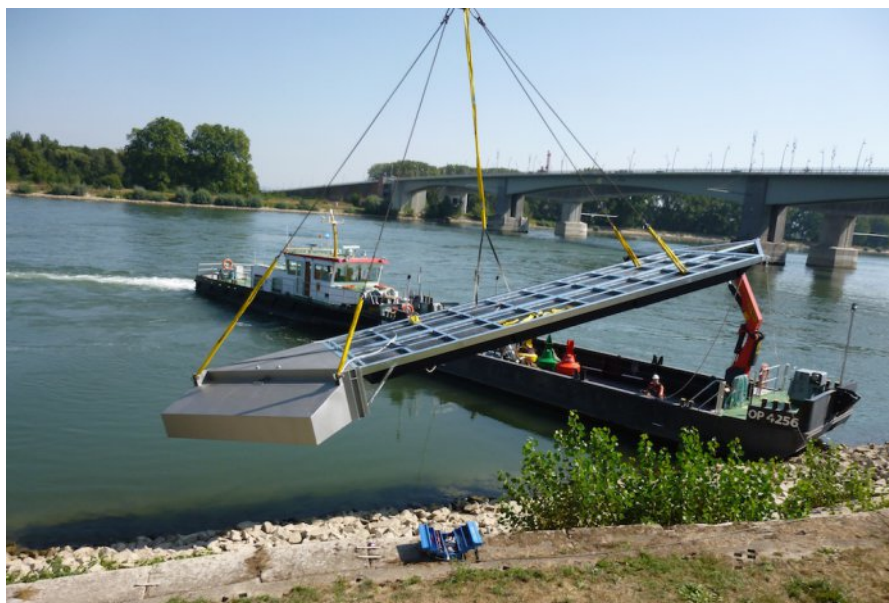
Montage der neuen Pritsche, Foto: Harold May
